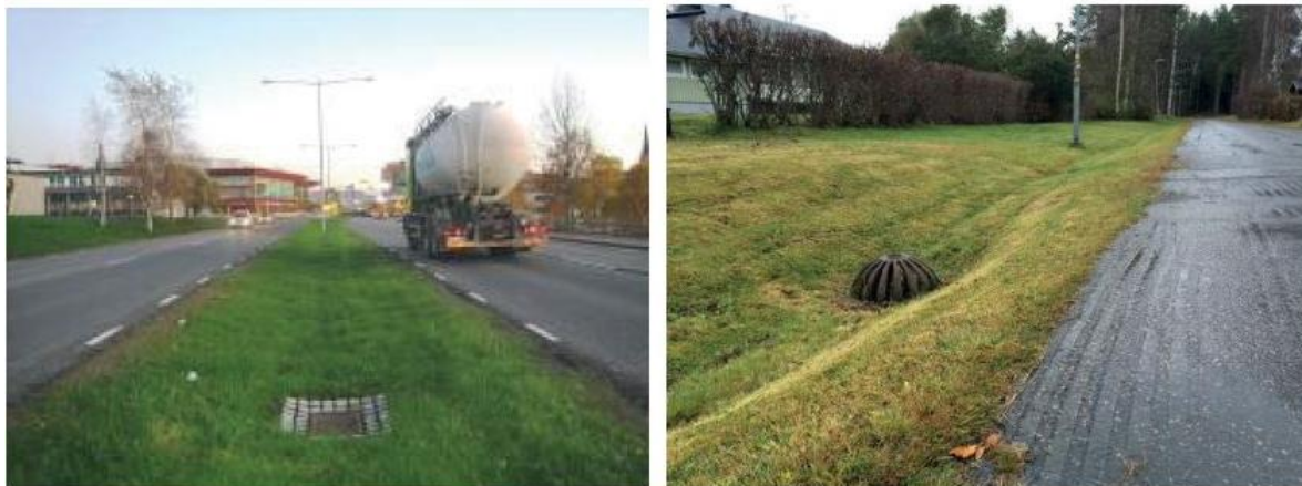
Figur 10. Två exempel på svackdiken. (Svenskt Vatten Utveckling, 2016)
