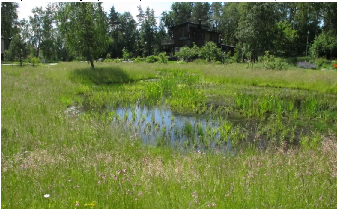
Figur 11. Exempel på torrdamm efter regn (Foto WSP, 2015)
