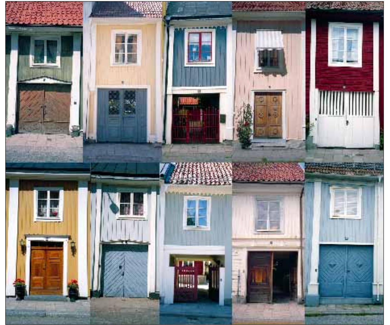
Enklaste slag av stående brädfodring och all utsmyckning koncentrerad till portalen och dörrsnickerierna. Ett karaktärsdrag som står sig än idag.
