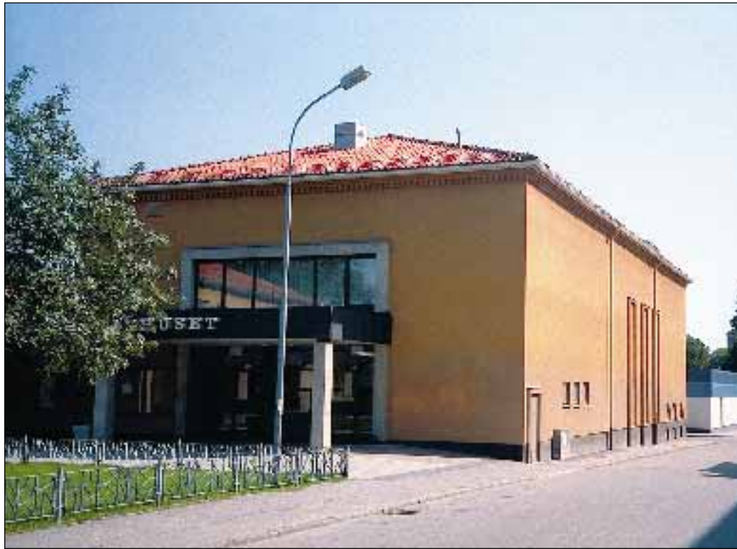
1948 uppfördes det nya Medborgarhuset. Byggnaden har trots den rådande funktis-stilen inslag av stilfull klassicism.
